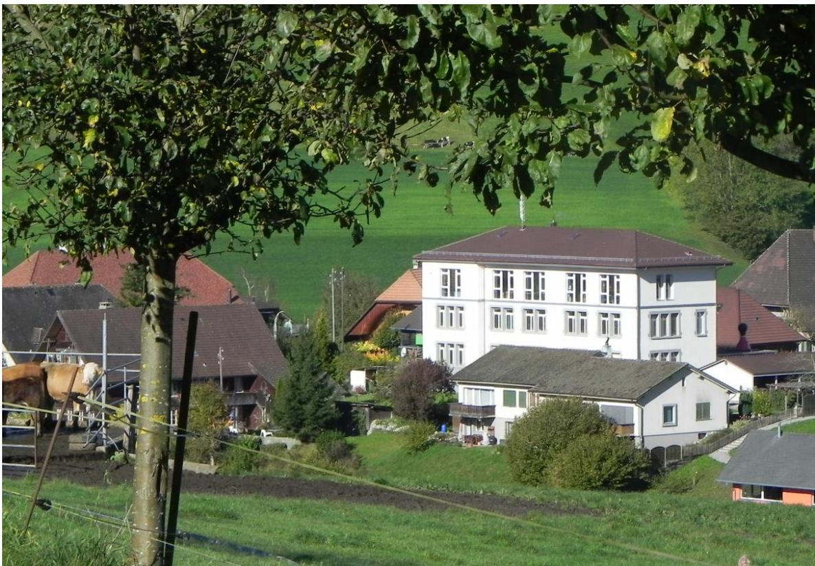
Sanierung 2014-2016. Zusätzliches Vollgeschoss, neues Satteldach mit guter Integration ins Dorfbild
