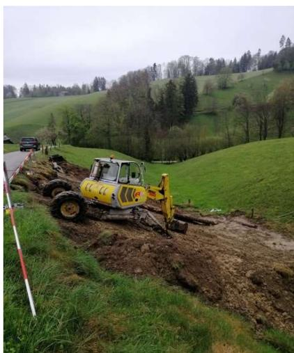
Ebenfalls konnte der abgerutschte Weg oberhalb des Sonnbergs in Richtung Sonnbergschürli wieder instand gestellt werden. Zudem ist die Rutschsanierung in der Dreien momentan in Arbeit und wird demnächst abgeschlossen. Wichtig ist bei dieser Sanierung vor allem, dass ein Abrutschen der Zufahrt verhindert wird.
