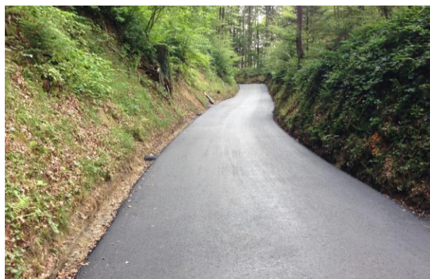
Leimgrabenstrasse, Bereich Hohle
